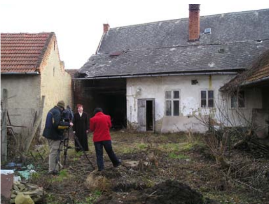
Průzkum porušeného objektu v Rostěnicích (součást projektu INTERREG IIIA) 2007.
