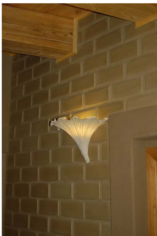
Sluštice - detail hliněné stěny v interiéru z režného hliněného zdiva
