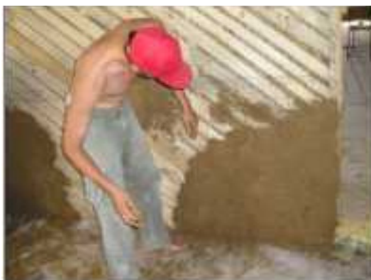
Nanášení omítky se slámou tradičním způsobem na workshopu ve Křtinách, 2004
