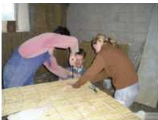
Příprava rákosových rohoží před uložením na stěnu kamenné kulturní památky jako podklad pod hliněnou omítku v Hostimí, 2005
