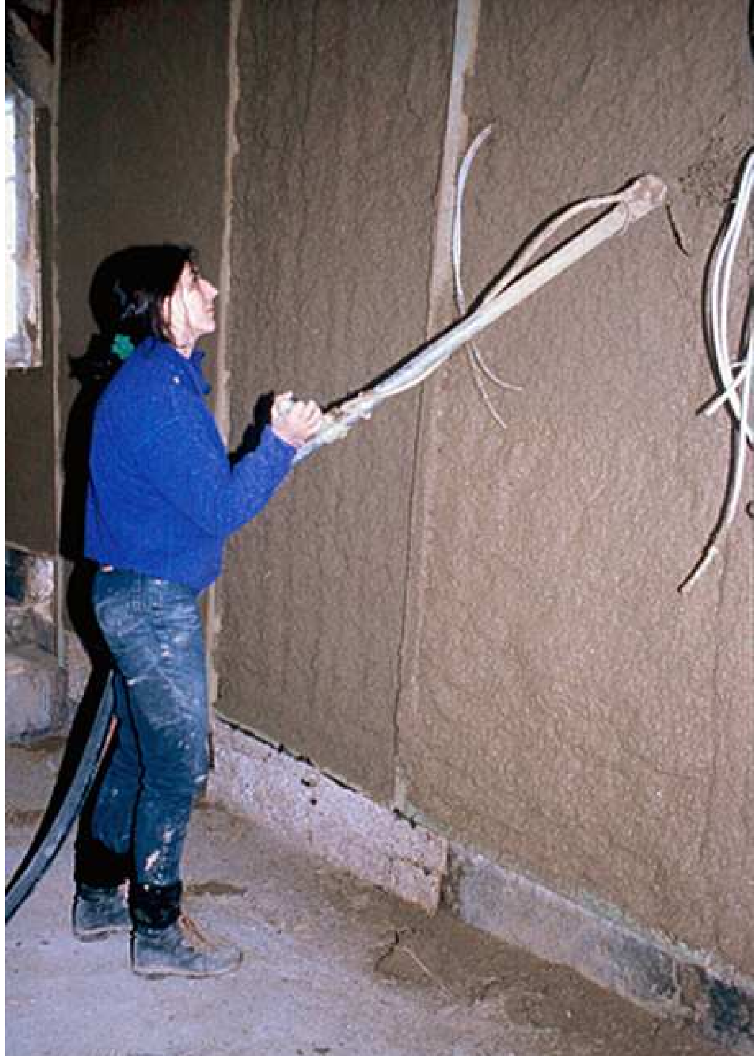
Stříkání hliněné omítky, Německo. © Claytec
